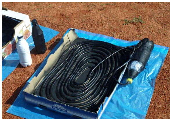
Obr. 2. Realizácia hadicového kolektora
