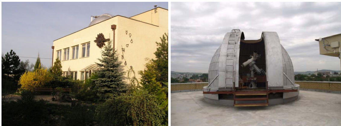
Obr. 1 Budova Hvezdárne v Rimavskej Sobote s kupolou
